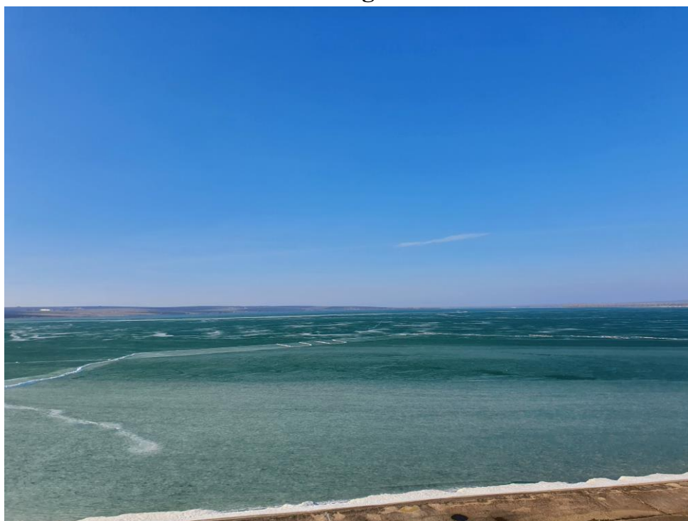
Fig. 11 Lacul de acumulare Costești-Stânca
